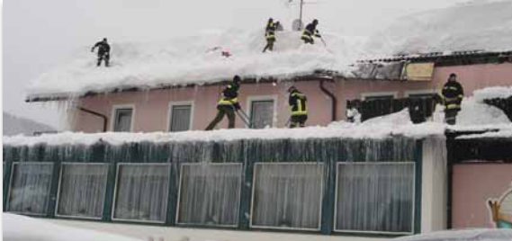
Abräumen des Schnees von einsturzgefährdeten Dächern im Rahmen des KHD-Einsatzes in Göstling, 2006.
