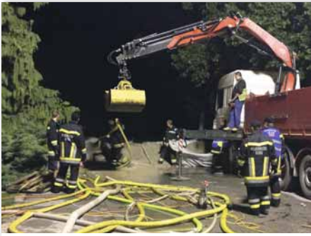
Das Jahrhunderthochwasser im Sommer forderte auch die Kameraden der FF Berg, im Bild bei Dammsicherungsarbeiten in Bad Deutsch-Altenburg, 2013.
