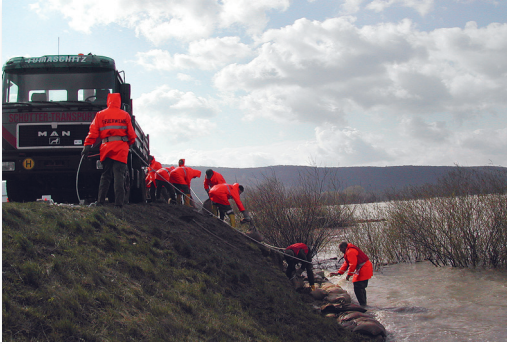
2002: Hochwassereinsatz am Damm zwischen Wolfsthal und Grenzübergang Berg. Der Damm, welcher undicht zu werden drohte, musste geschützt werden.
