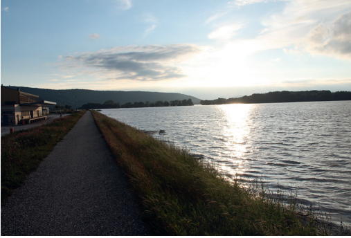
2013: Hochwassereinsatz. Der Damm beim Grenzübergang Berg musste abgedichtet werden, da das extrem gestiegene Donauwasser zu Undichtheiten führte.
